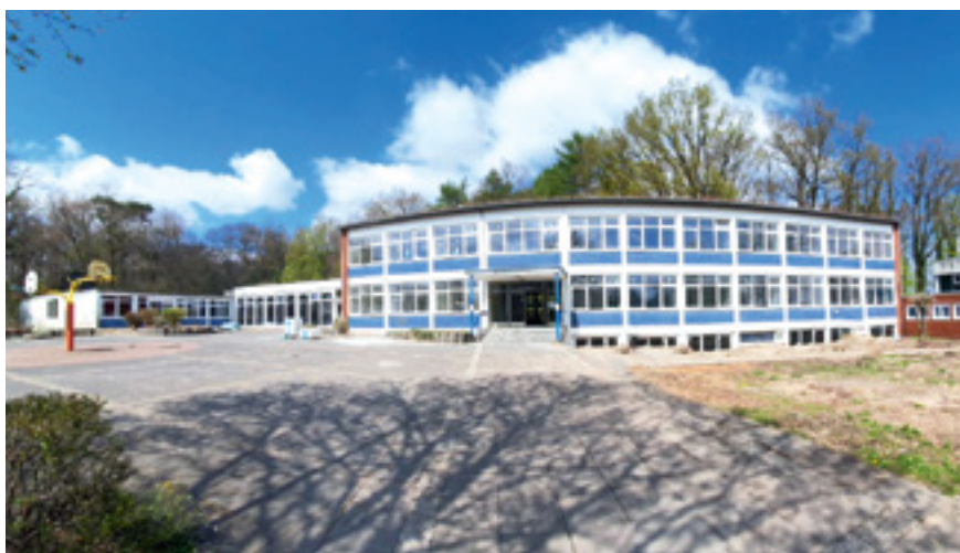
Die ehemalige Förderschule in Petershagen wurde zum Iuvare Pflegecampus umgebaut.
